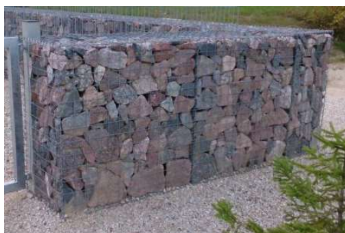
Foto 8. Vasakul: projekti jaoks sobiv 50x50x50 tagasihoidliku 7,5x7,5 cm silma mõõduga gabioonikorv – kaks korvi üksteise peale kinnitatuna moodustavad 0,9 meetri kõrguse seina (Allikas: ABPolar). Paremal: näide
